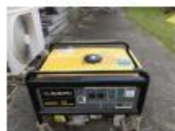
非常用発電機を作動
